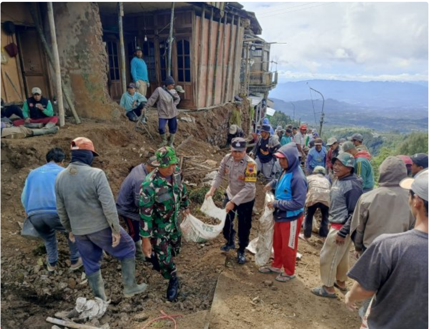
(Foto Dokumen) : Gotong royong pembersihan material longsor
